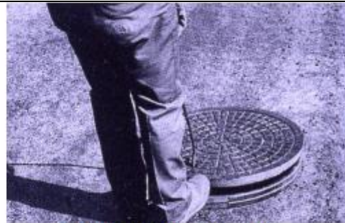
b. Install Manhole Riser Ring
