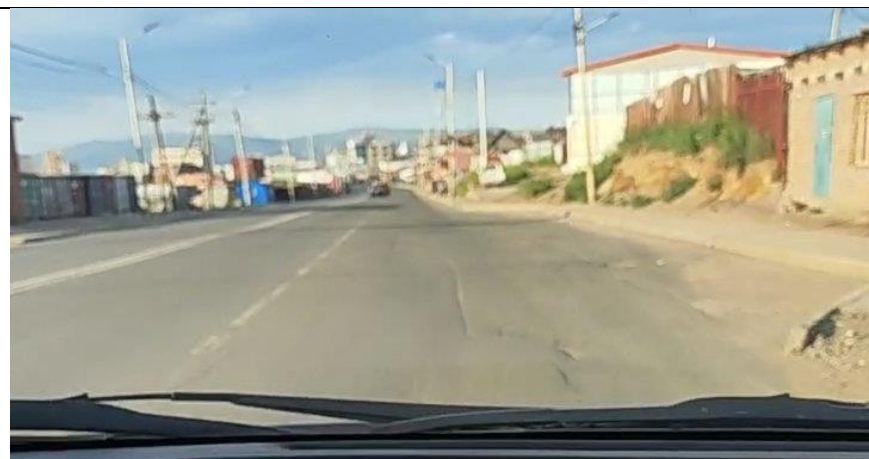
Аливаа зогсоол болон зорчих хэсгийн нийлэх шугамд дэлгэмэл чулуун хашлага хийвэл энэхүү ус нь асфальтбетоныг эвдэхгүй байх сайн талтай. Зогсоолын карман их эвдрэлтэй байна. Нөхөөс хийж тэгшлэх шаардлагатай.
