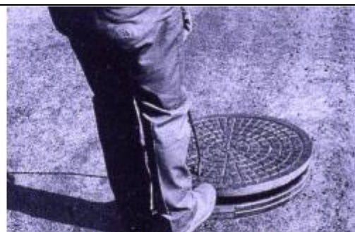
b. Install Manhole Riser Ring
