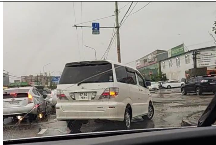
Тус замын орц гарц дээр ус ихээр тогтож хучилт нь эвдэрсэн байна.
