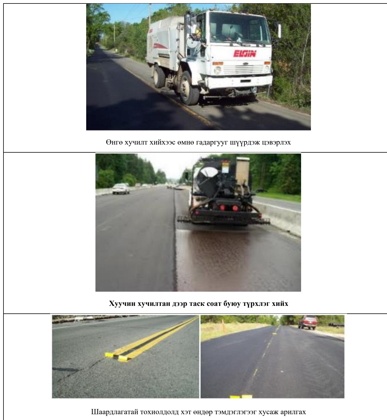
Зураг 1. Өнгө хучилт авах бэлтгэл
