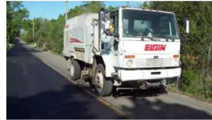
Өнгө хучилт хийхээс өмнө гадаргуут шүүрдэж цэвэрлэх
