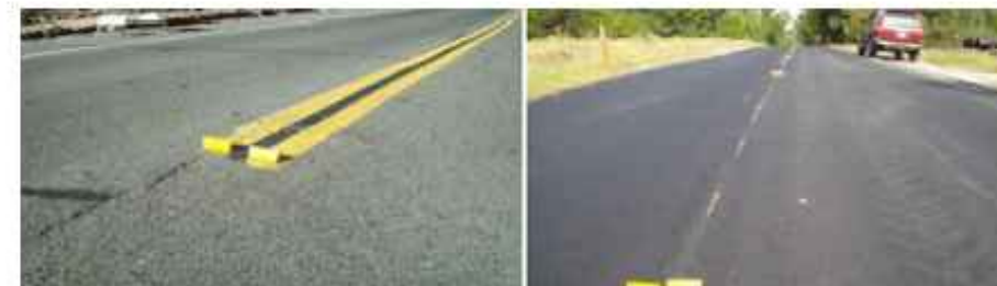
Шаардлагатай тохиолдолд хэт өндөр тэмдэглэгээг хусаж арилгах
