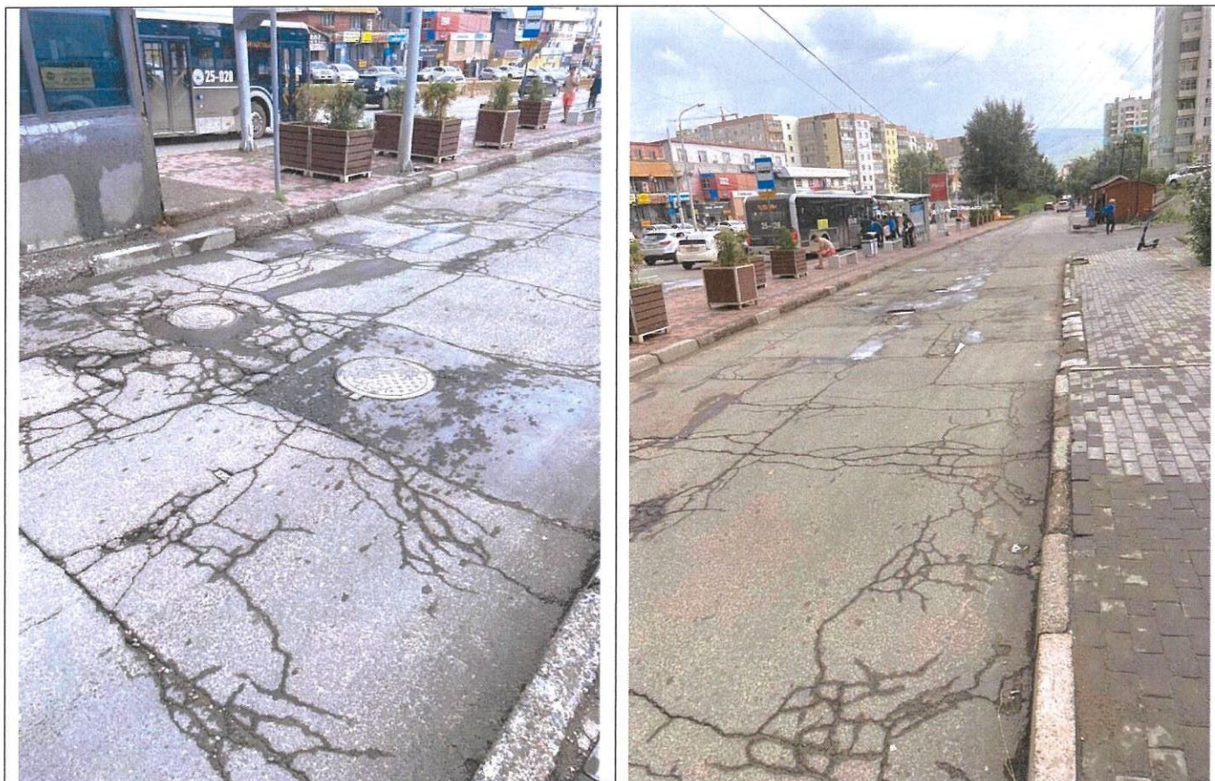
Замын ихэнх хэсэгт торон хагарал үүссэн.
