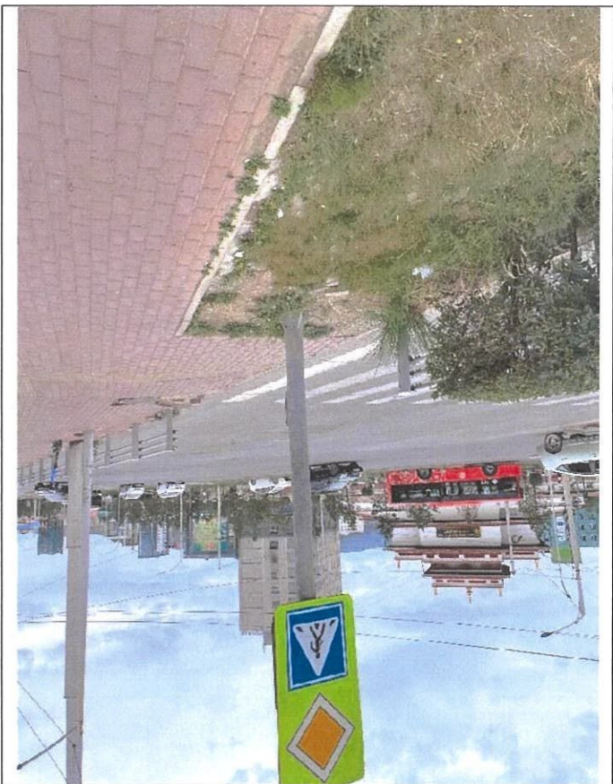
Замын мөмдгөл зурвалж, зарим хэсэгт шалбарал хийгдсэн байна.
