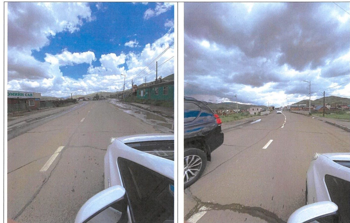
Замын урд хэсэг баруунаас зүүн чиглэлд авто замын урд хэсэгт дагуу хагарал ихтэй.
