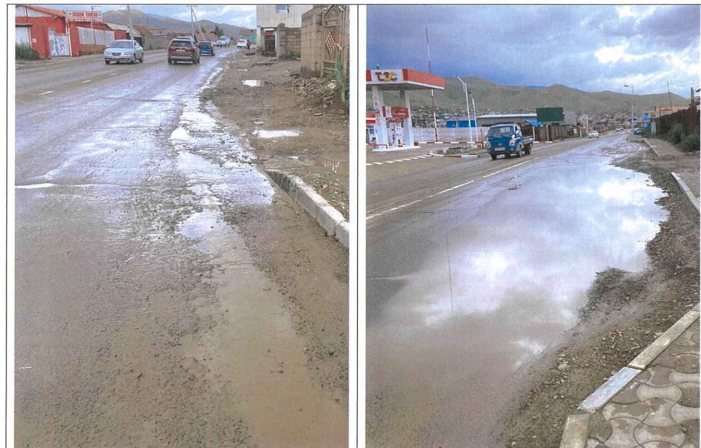
Замын дагууд нүхтэй хэсгүүдэд ус тогтсон байсан.
