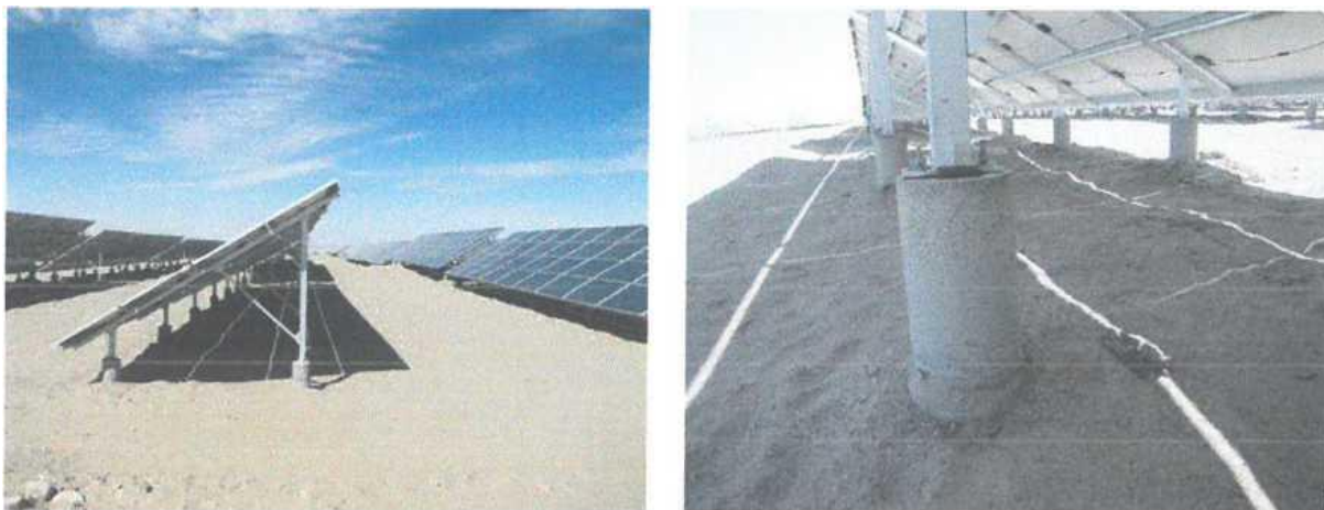
Зураг 17. Шон хэлбэрийн бетон суурь
