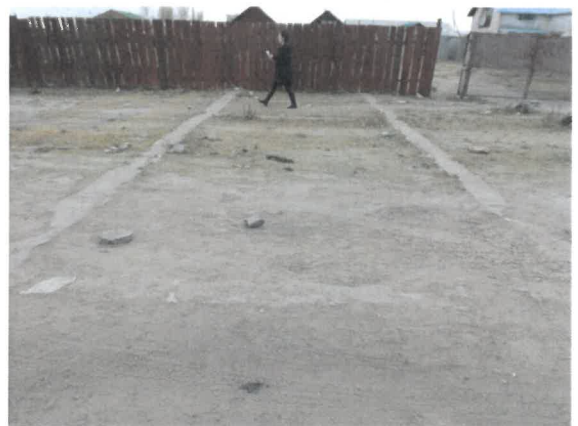
Трассд орсон зайлуулагдах хуучин байшингын бетон суурь
