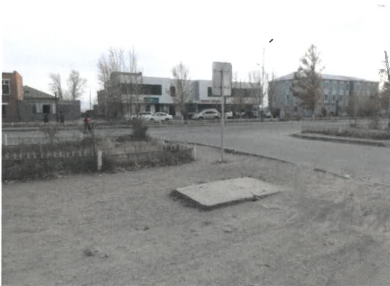
Трассын эхлэл инженерийн шугам шугам сүлжээ трассд орсон ба зиг заг хучилттай
