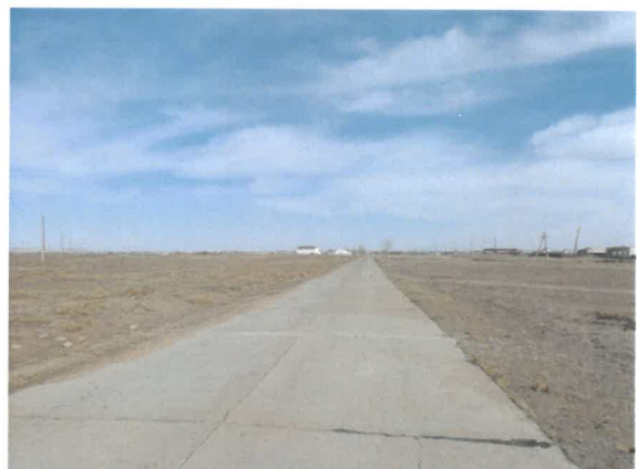
Уулзвар-2 Аймгийн төвөөс нисэх онгоцны буудалруу бетон замтай огтлолцож буй хэсэг
