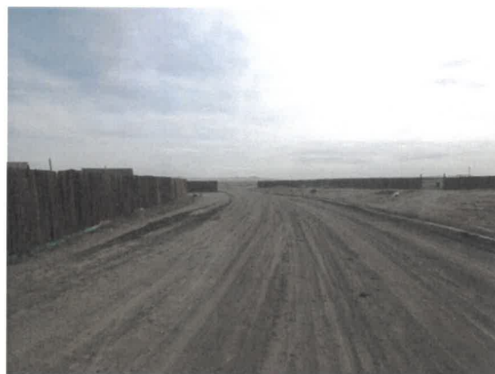
Трассын дагуу одоо байгаа хөрсөн зам /Автогрейдээрээр хуссан байдал/
