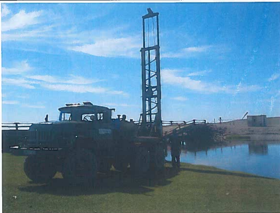
Фото зураг №2. Ц-3, Ц-1-с 20м зайд өрөмдлөг явуулж байна.
