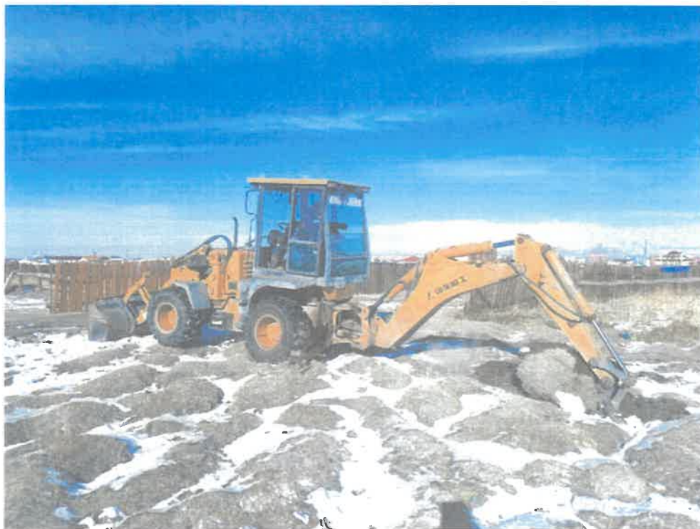
/Фото: Дов сондуул, хөрсний устай хэсэгт шурф малталт/
