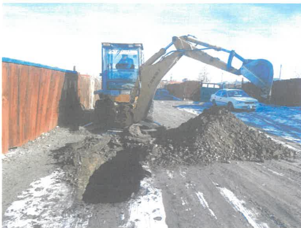
/Фото: Гудамжинд шурф малталтын үйл явц/
