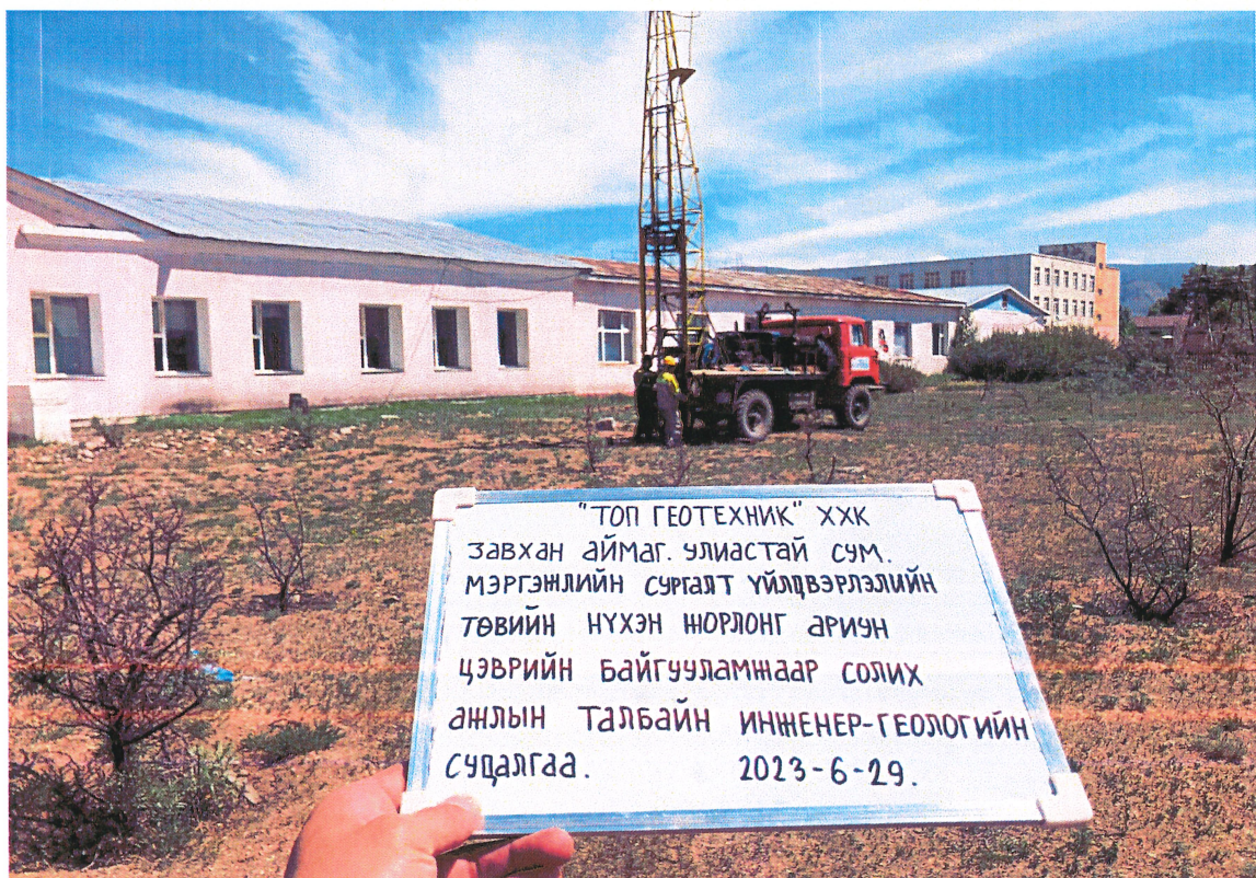
Фото зураг: Өрөмдлөгийн явц болон барилга баригдах талбай, талбайд илэрсэн ул хөрс
