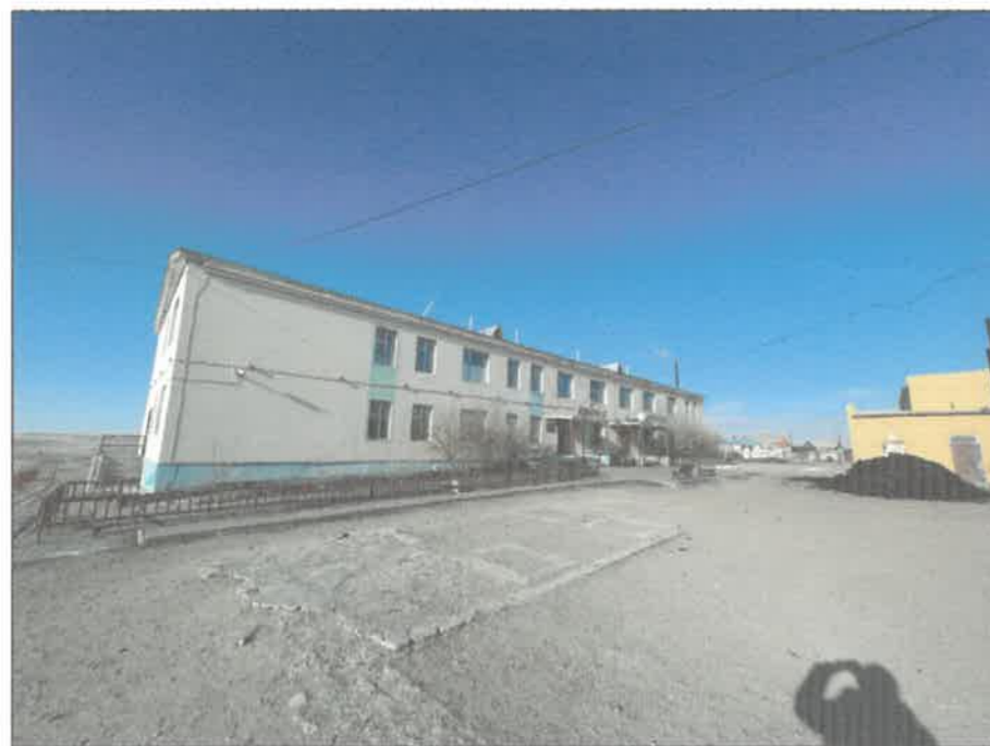
Зураг №4. Дотуур байр, цэцэрлэгийн барилга
