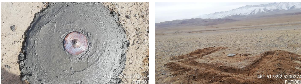
Зураг 2. Трассын дагуу 2 км тутамд шинэ цэг суулгаж буй байдал
