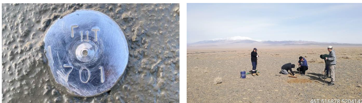
Зураг 2. Трассын дагуу 2 км тутамд шинэ цэг суулгаж буй байдал
