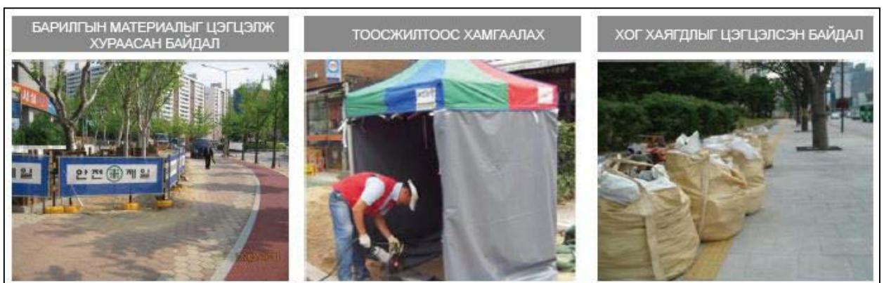
61-р зураг - Барилгын талбайн орчны нөхцлийг хангасан байдал (ЖИШЭЭ)
