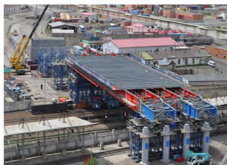
Зураг 6.12 Гулсуулан угсрах аргачлал (Нарны гүүр төсөл дээр ашигласан)
