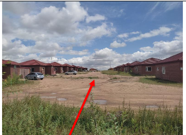
Км 0+000 Трасс орж буй явган замын хавтан, төмөр хашаа, ногоон байгууламжийг зайлуулахаар төлөвлөсөн.
