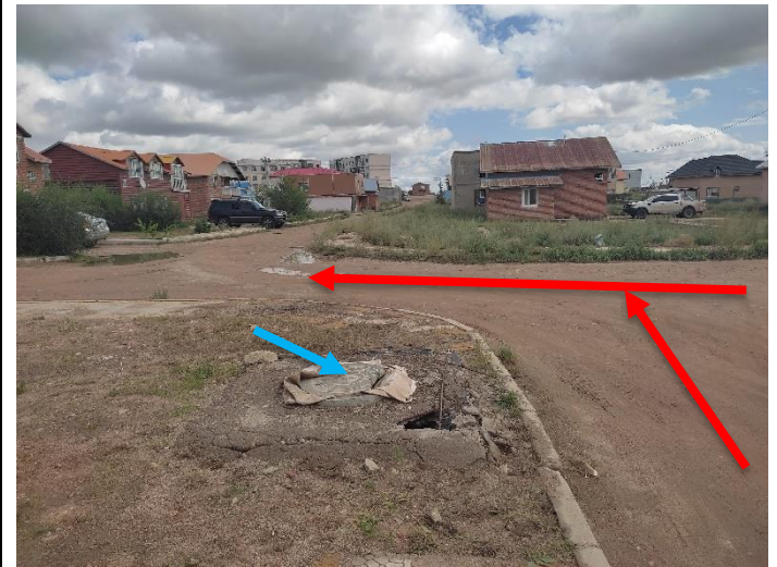
Трассын төгсгөл Км 0+097.74 Явган замд орж буй цэвэр, бохир усны шугамын худгийг өндөрлөж хүчитгэхээр төлөвлөсөн.
