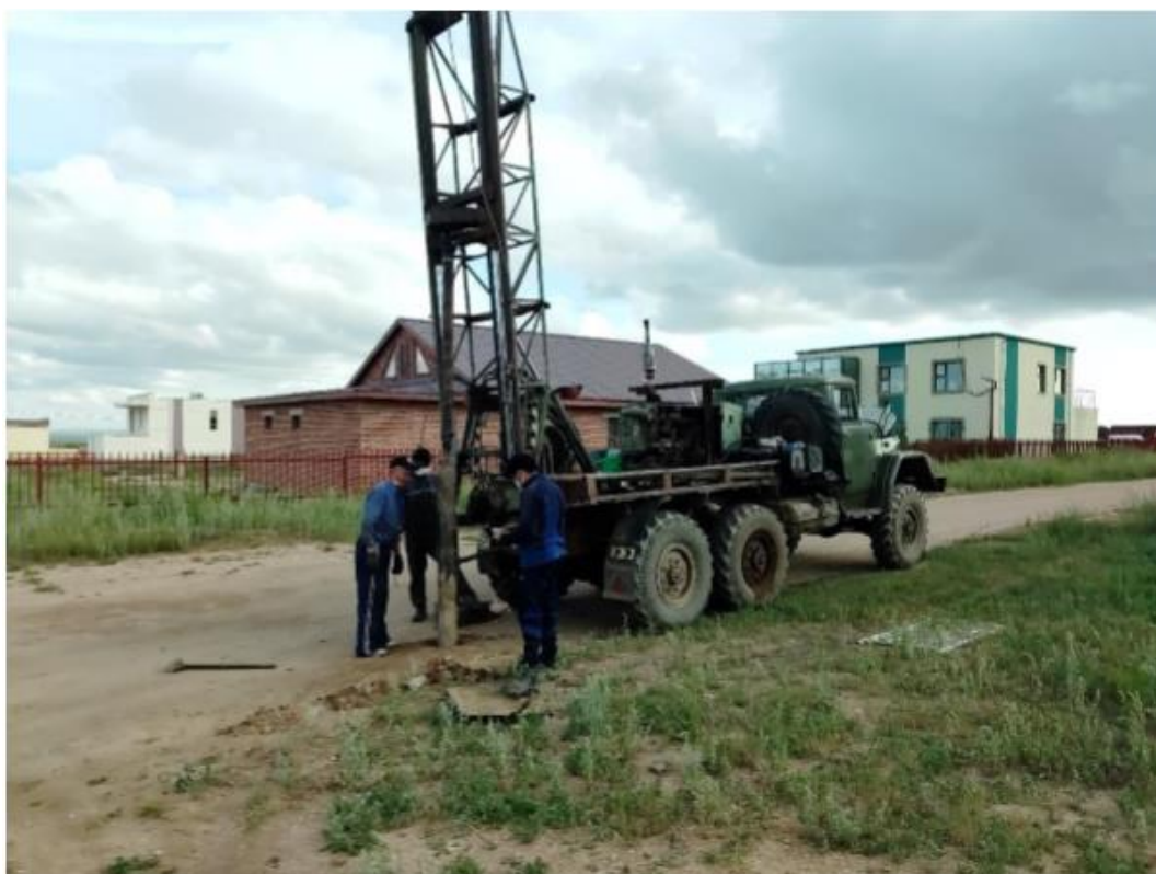
Зураг 8. Өрөмдлөг хийж буй зураг
