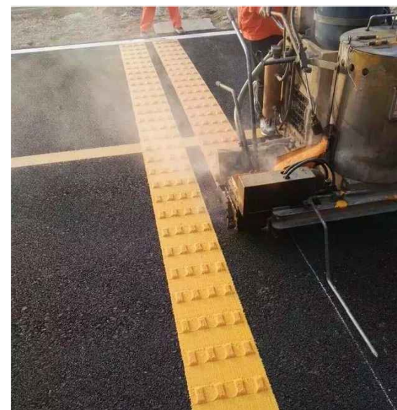
АСФАЛЬТБЕТОН ЯВГАН ЗАМ БОЛОН ТЕРМОПЛАСТИК ДАКЛЕТОН ЗАМЫГ ХИЙСЭН ЖИШЭЭ ЗУРАГ
