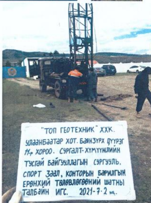
Фото зураг: Өрөмдлөгийн явц болон барилга баригдах талбай, талбайд илэрсэн ул хөрс
