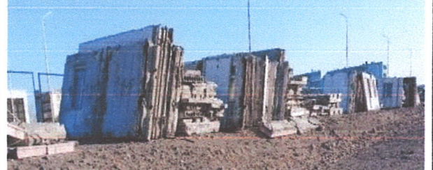
3,4-р зураг. Талбай дээр буулгасан угсармал элементүүд.
