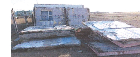
3,4-р зураг. Талбай дээр буулгасан угсармал элементүүд.
