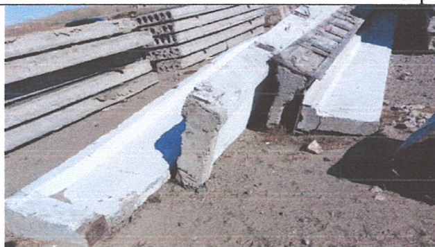
3,4-р зураг. Үйлдвэрийн талбайд буулгасан суурийн блок, хавтан.
