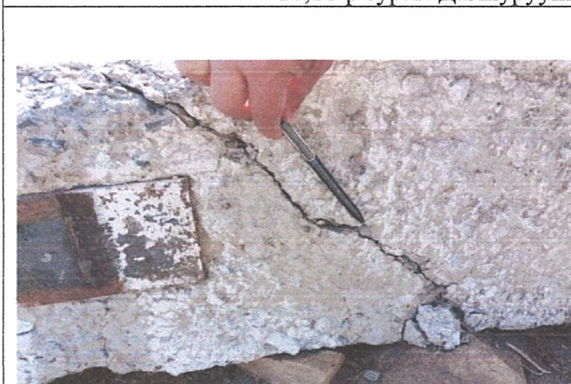
12,13-р зураг. Дамнууруны бетоны бат бэх, ан цав.
