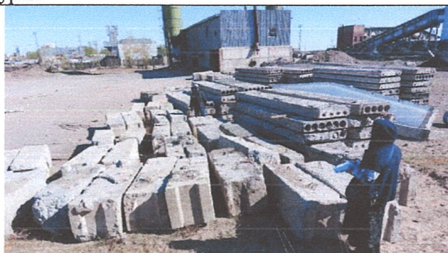
3,4-р зураг. Үйлдвэрийн талбайд буулгасан суурийн блок, хавтан.
