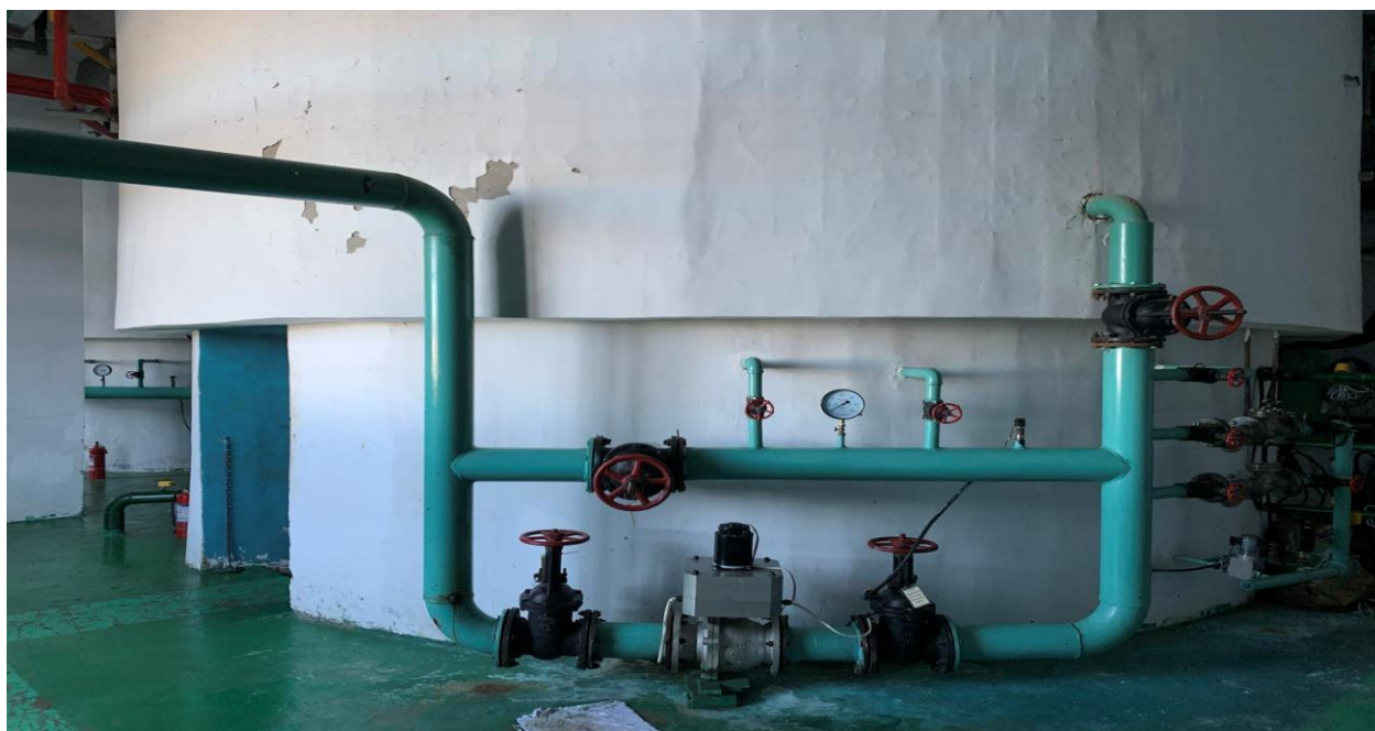
Зураг 2. Турбинруу холболтын систем
