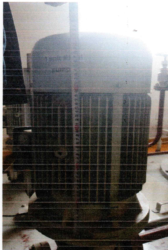
Зураг 1. Governor-ын тосны насос тосны банкинд суурилагдсан байдал
