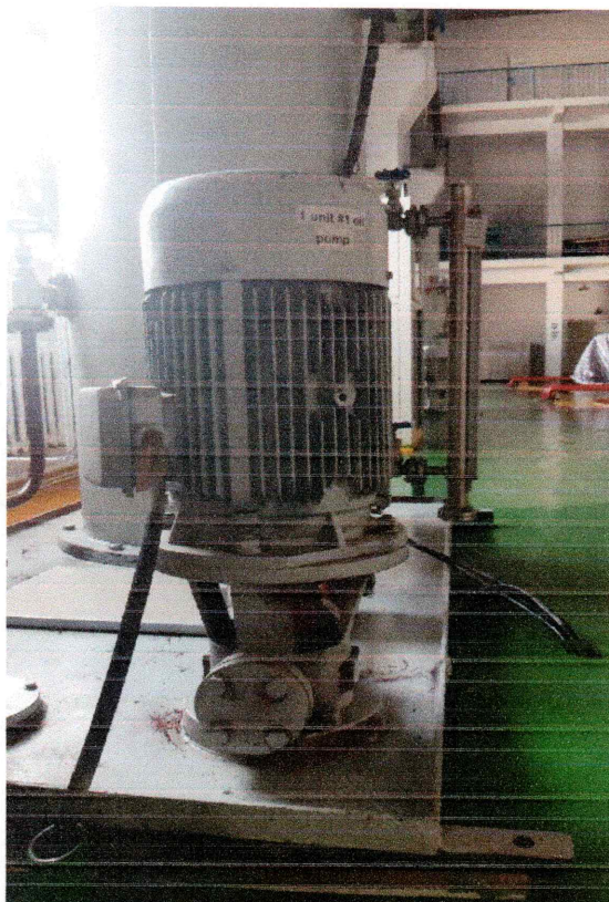
Зураг 1. Governor-ын тосны насос тосны банкинд суурилагдсан байдал
