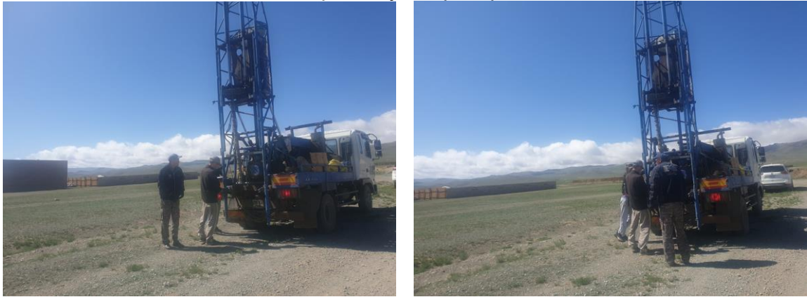
Фото зураг: Төлөвлөж буй Барилгын талбайд өрөмдлөг хийж байгаа нь Цооног №19
