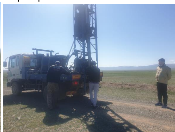
Фото зураг: Төлөвлөж буй Барилгын талбайд өрөмдлөг хийж байгаа нь Цооног №10
