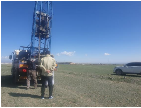
Фото зураг: Төлөвлөж буй Барилгын талбайд өрөмдлөг хийж байгаа нь Цооног №9
