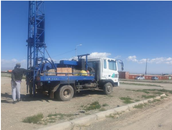
Фото зураг: Төлөвлөж буй Барилгын талбайд өрөмдлөг хийж байгаа нь Цооног №25
