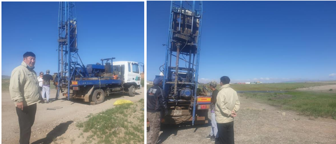
Фото зураг: Төлөвлөж буй Барилгын талбайд өрөмдлөг хийж байгаа нь Цооног №5
