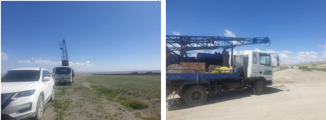
Фото зураг: Төлөвлөж буй Барилгын талбайд өрөмдлөг хийж байгаа нь Цооног №31
