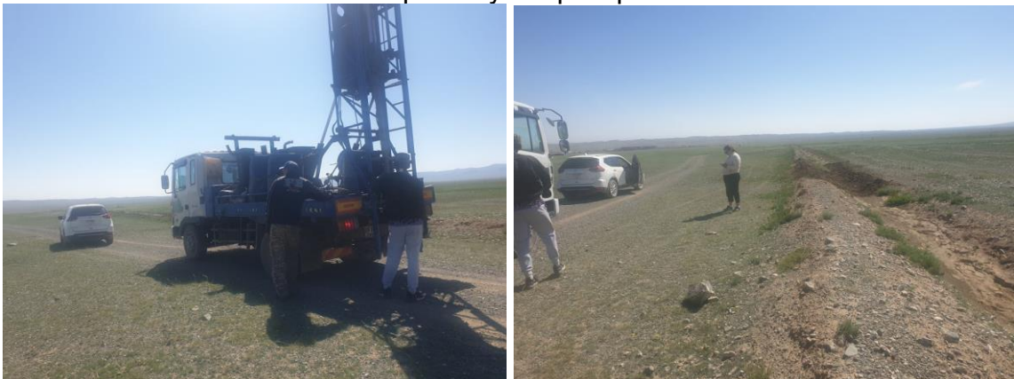
Фото зураг: Төлөвлөж буй Барилгын талбайд өрөмдлөг хийж байгаа нь
