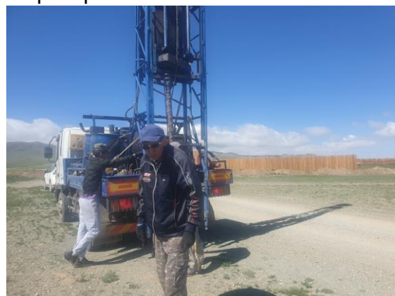
Фото зураг: Төлөвлөж буй Барилгын талбайд өрөмдлөг хийж байгаа нь Цооног №24
