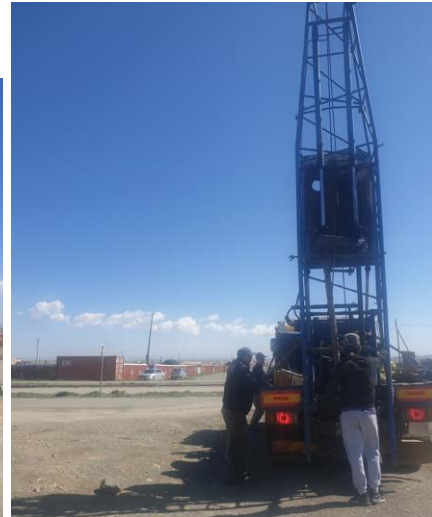
Фото зураг: Төлөвлөж буй Барилгын талбайд өрөмдлөг хийж байгаа нь Цооног №25
