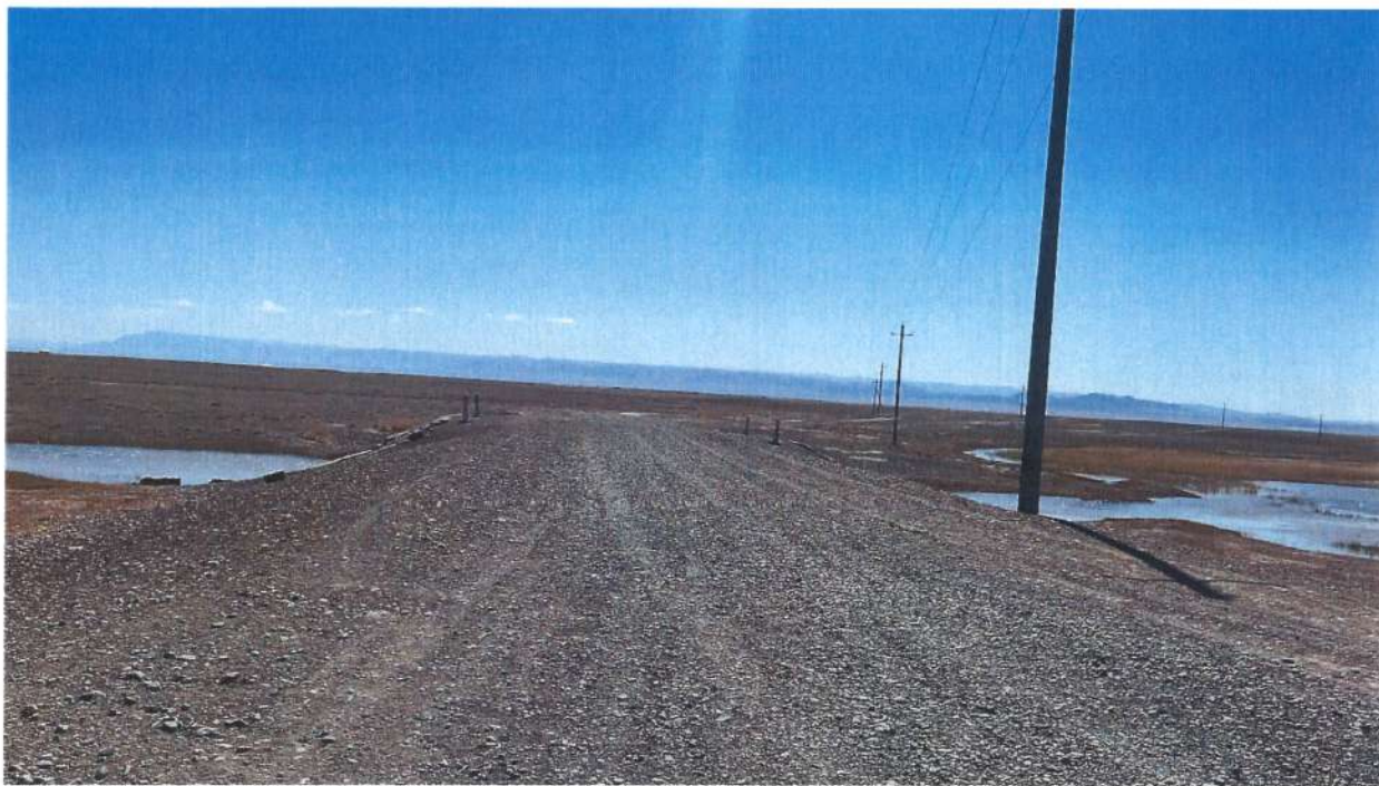
КМ 16+380 дахь одоо байгаа 2.5x2.0x3 хос төмөрбетон дөрвөлжин хоолой
