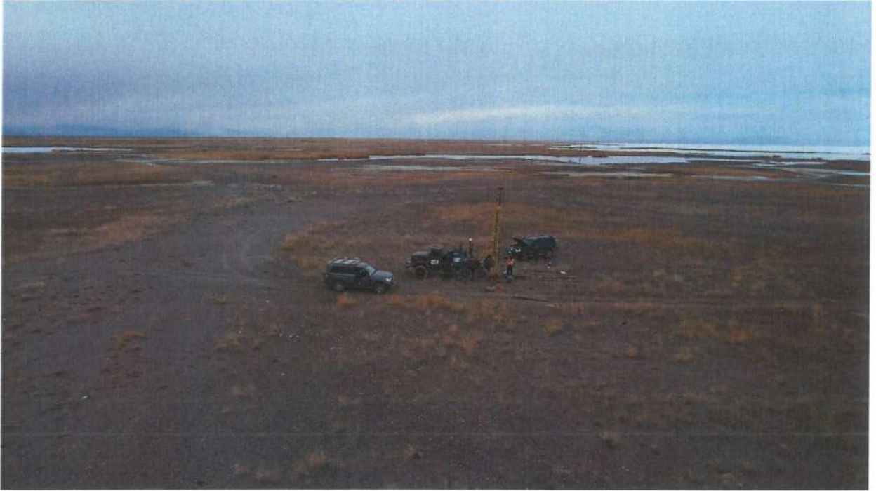
Трассын дагууд инженер геологийн өрөмдлөг хийж буй байдал
