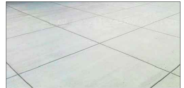
Бетон шалны шов хийгдсэн жишээ
