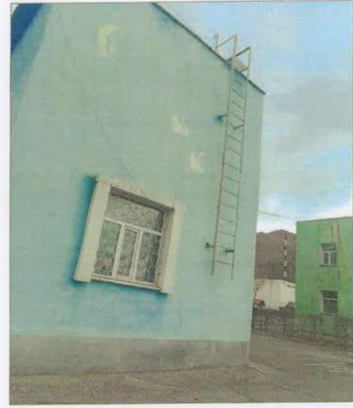
Буулгах металл дээврийн шатны одоогийн байдал
