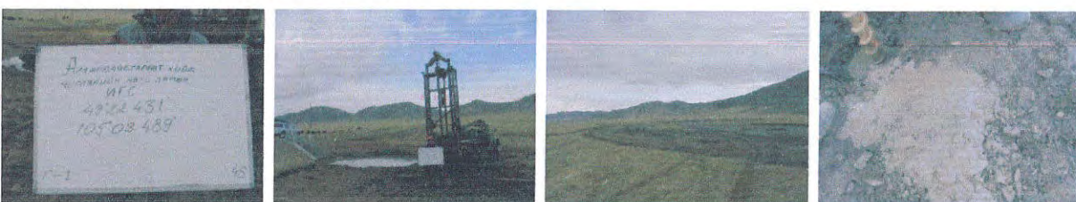
Цооног № 46. Байршил, өрөмдлөг, дээжлэлт.
