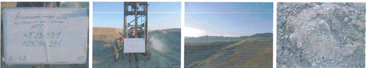
Цооног № 52. Байршил, өрөмдлөг, дээжлэлт.
