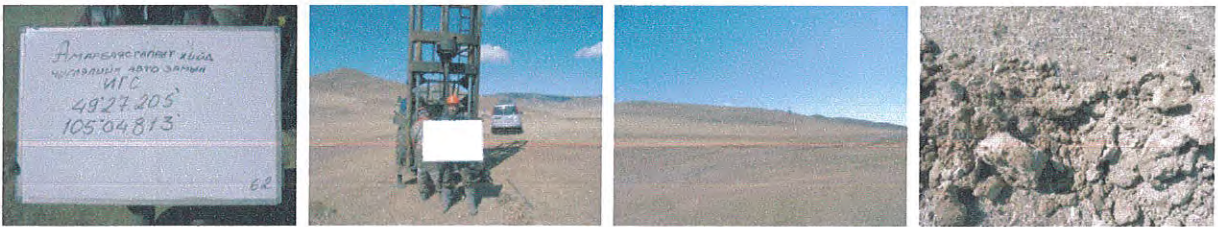
Цооног № 63. Байршил, өрөмдлөг, дээжлэлт.
