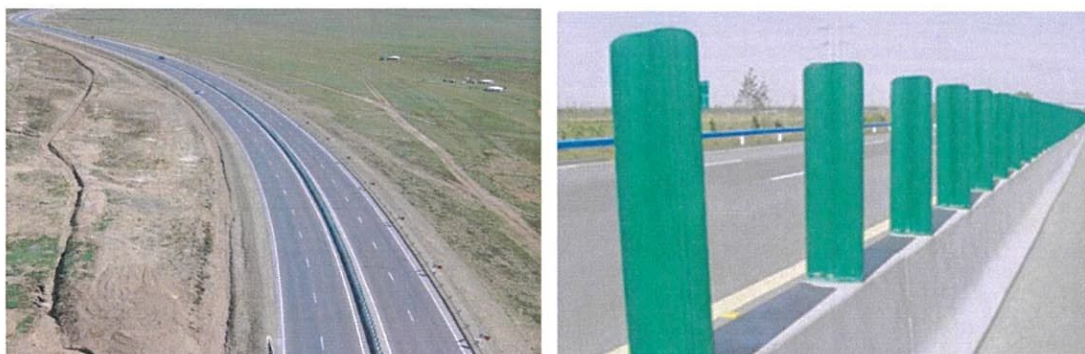
Зураг 17. Зорчих хэсгийн голд байрлах төмөрбетон зааглах хашлага, гэрлийн гялбаа сарниулагч
