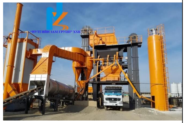
“Нутгийн зам” ХХК-ийн асфальтбетон үйлдвэр
