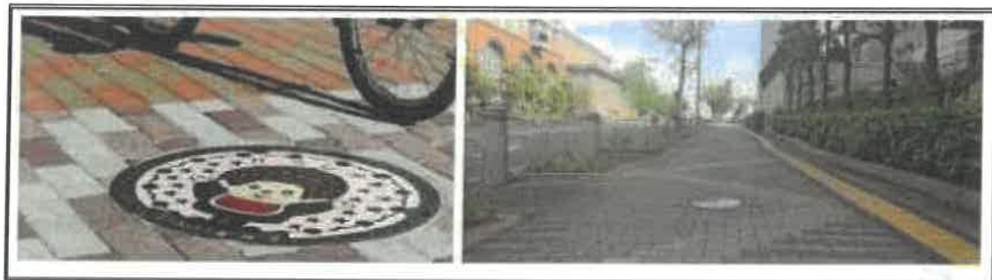
Зураг №3 Ширмэн тагийг явган замын түвшинтэй нэг түвшинд суулгана.
