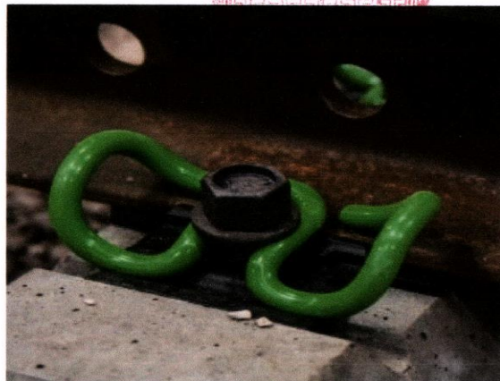
ЗУРАГТ. P-50 ЗАМ ТӨМӨРТЭЙ ГАЗРЫН ҮЕНИЙ ДУНД ХЭСГИЙН БЭХЭЛГЭЭНИЙ УГСРАГДСАН БАЙДАЛ: 1-босо боолт, 2-гайка, 3-хавтгай шайба 4-пүрш, 5-хавтгай уян даруулга, 6-уян даруулганы суудал, 7-зөөлөч, 8-хулсан нэгэс
