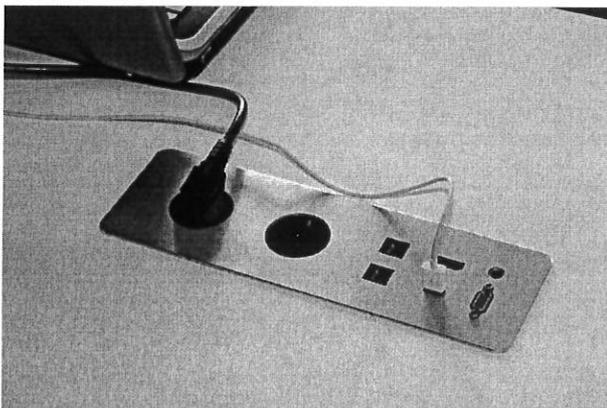
Дундын оффисын ширээнүүдэд 50 разетка суурилуулах, разеткууд нь USB оролтоор цэнэглэдэг байх
